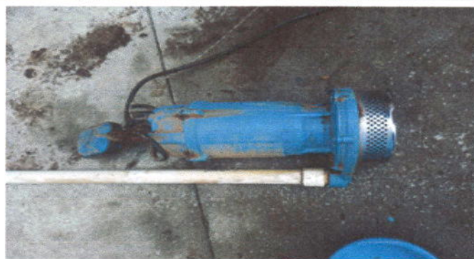
Foto 9: Sustitución de bomba de agua, área general.
