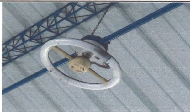
Foto 7: Sustitución de lámparas tipo LED, módulo 1 y 2.
