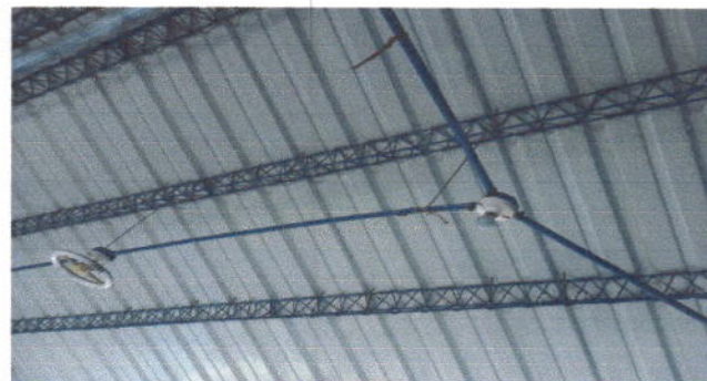
Foto 8: Sustitución de lámparas tipo LED, módulo 1 y 2.
