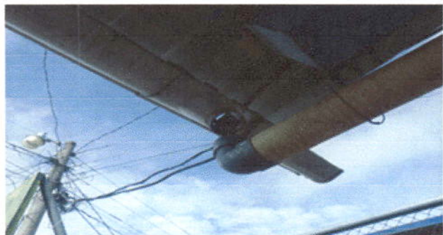
Foto 1: Sustitución de canal y bajadas de agua, módulo 2.
