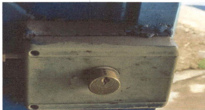
Foto 2: Sustitución de chapa de una puerta, módulo 2
