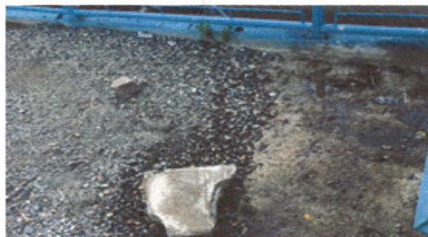
Foto 4: Sustitución de de piso de torta de cemento, módulo 2.
